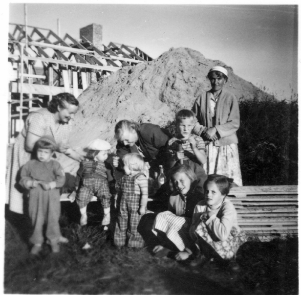
Kesätie 41 Kurttiloiden rakennustyömaa – edellisen kuvan vihreä talo.
